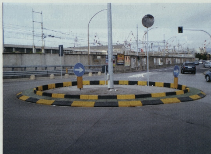
Slika 6 • Montažno krožno križišče, izvedeno iz prefabriciranih betonskih elementov; Genova
