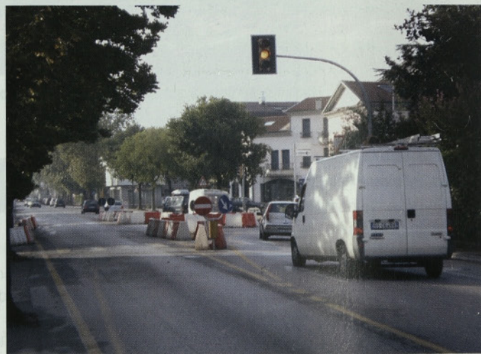
Slika 9 • Semafor v režimu »rumena utripajoča« v trikrakem montažnem krožnem križišču; San Dona di Piave
