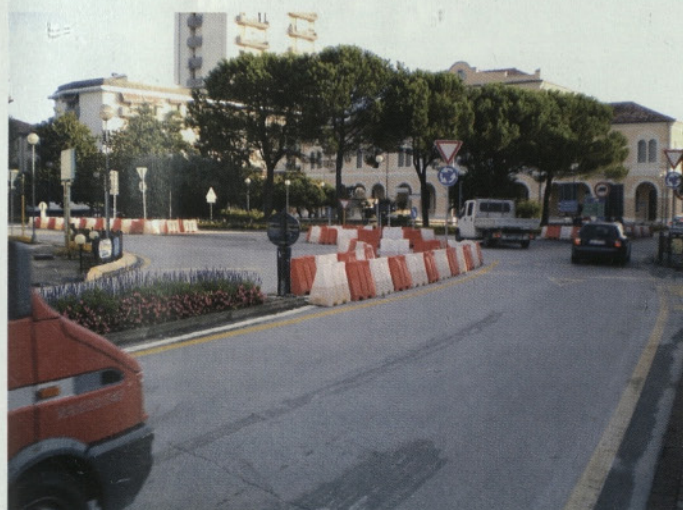
Slika 4 • Ločilna otoka v montažnem krožnem križišču; Cannes
