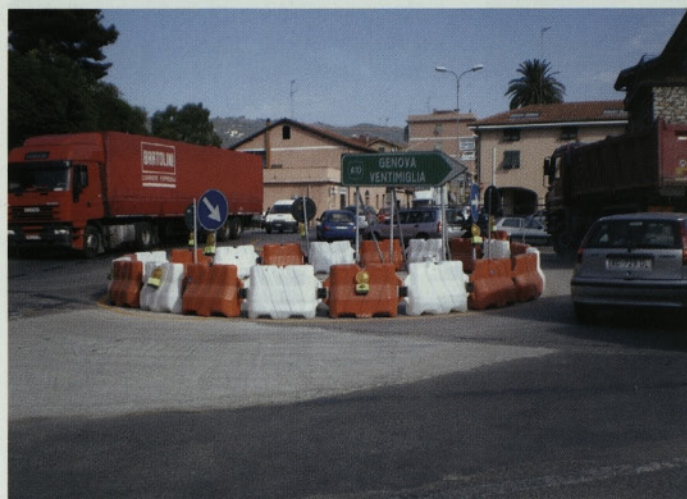
Slika 8 • Sredinski otok montažnega krožnega križišča, izveden z začasnimi ločilnimi ograjami iz umetnih snovi; San dona di Piave
