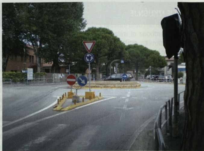
Slika 7 • Montažno krožno križišče, izvedeno iz delineatorjev; Cinque Terre
