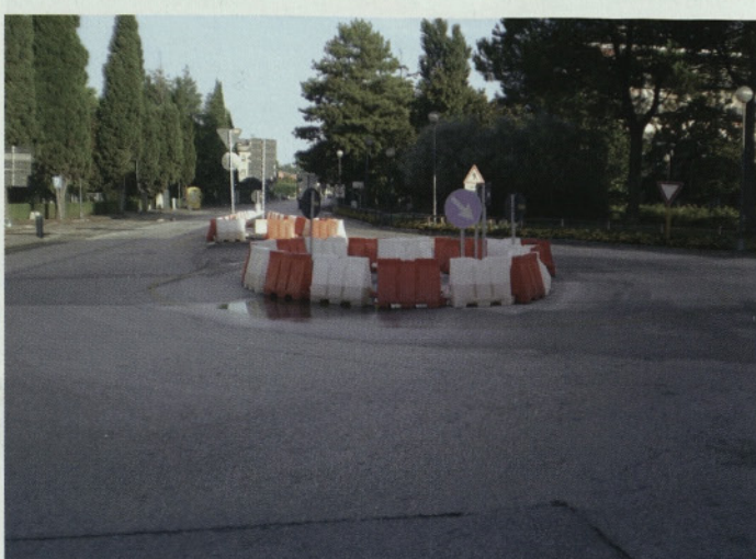
Slika 5 • Sredinski otok v montažnem krožnem križišču; Cannes
