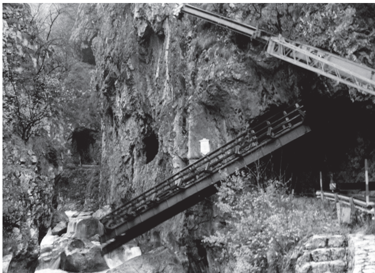
Slika 16: Odstranjevanje mostu leta 1999 Figure 16: Removal of the bridge in 1999
