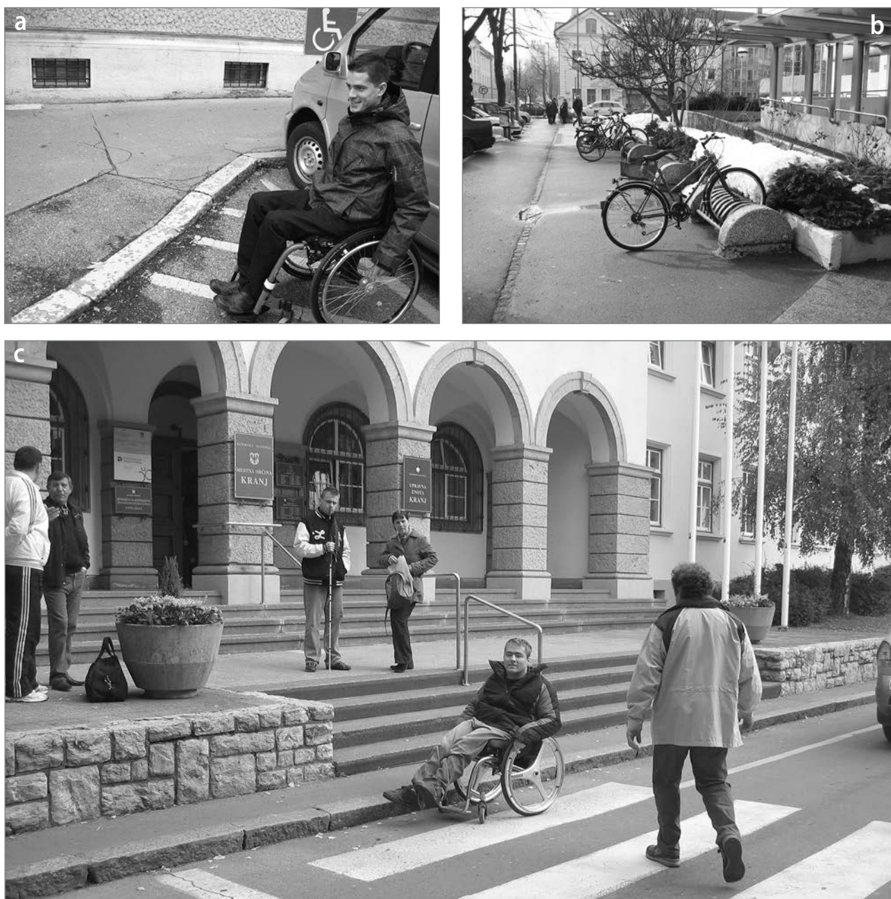
Slika 4: (a) Robnik brez poglobitve; (b) kolesa, korita za rože in drugo ulično pohištvo na dostopni poti so lahko ovira za slepe in slabovidne; (c) slabo urejen prehod za pešce.
