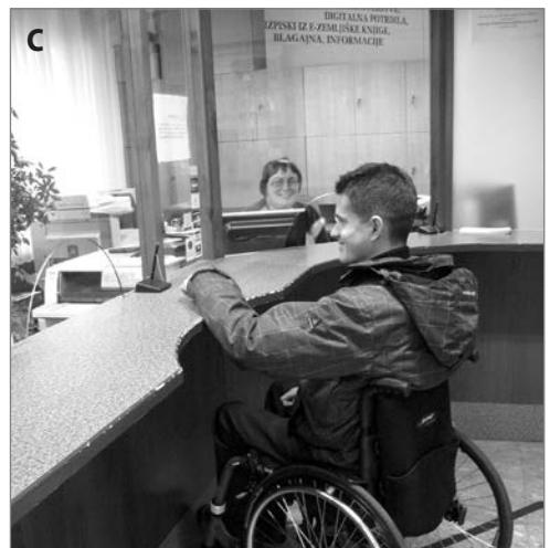
Slika 16: (a) Ob robu hodnika konzolno nameščen aparat za razvrstilne listke pomeni oviro na poti pri gibanju slepe osebe, manj primerna je tudi nameščenost, ki od sedečega zahteva dodaten napor; (b) neprimeren pult za poslovanje s strankami – njegovo polno pročelje onemogoča približanje, njegova višina pa komunikacijo; (c) primer primerne višine pulta za poslovanje s strankami, tudi pročelje pulta je vsaj delno umaknjeno v notranjost, kar osebi na invalidskem vozičku omogoča večje približanje.
