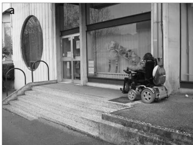
Slika 9: (a) Primer preozkega vhodnega prostora za varno vstopanje v objekt; (b) primer dobro urejene klančine v kombinaciji s stopnicami in dovolj prostorne vstopne ploščadi za manevriranje invalidskega vozička
