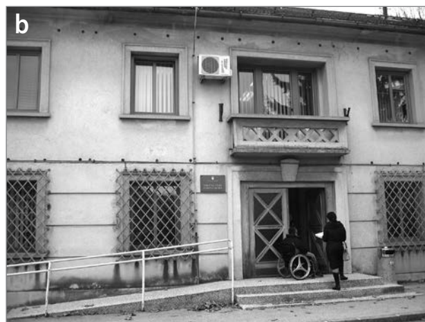
Slika 9: (a) Primer preozkega vhodnega prostora za varno vstopanje v objekt; (b) primer dobro urejene klančine v kombinaciji s stopnicami in dovolj prostorne vstopne ploščadi za manevriranje invalidskega vozička
