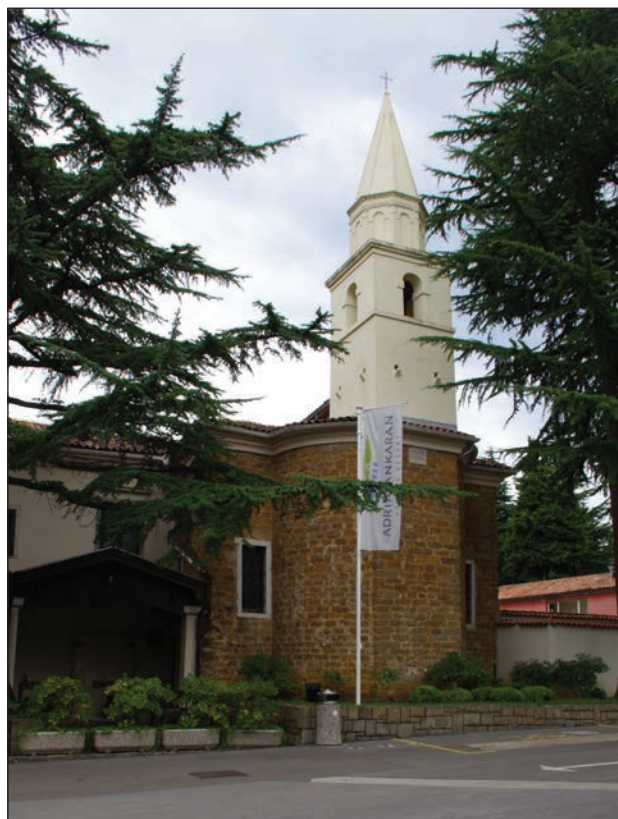
Slika 2: Pogled na cerkev z zvonikom (avtor fotografije: Ines Unetič)
