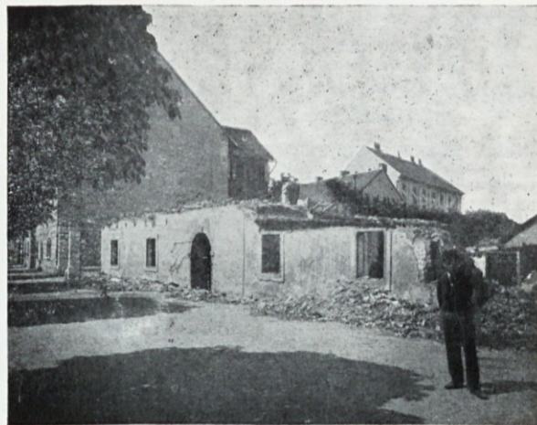
Pogled na desno stran Marije Terezije ceste (z Dunajske ceste) prej.
