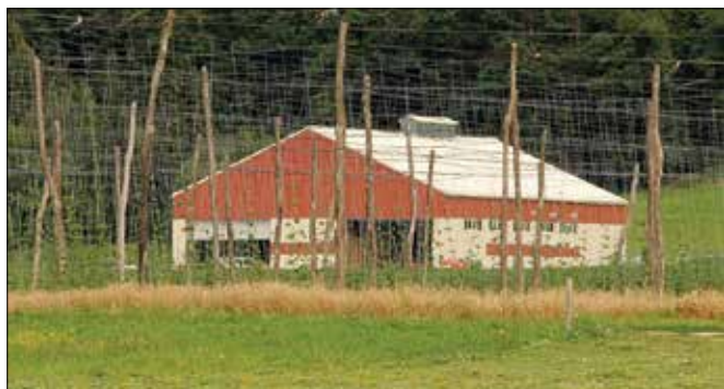
Objekt, ki je namenjen obiranju, sušenju in skladiščenju hmelja, v gradnji (foto: Igor Solar)
