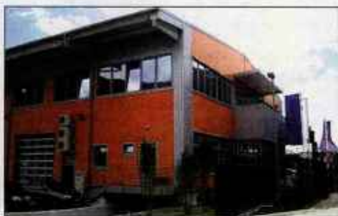
Novo poslovna stavba avto-prevozniškega podjetja SIGR Bizjak na Jesenicah
