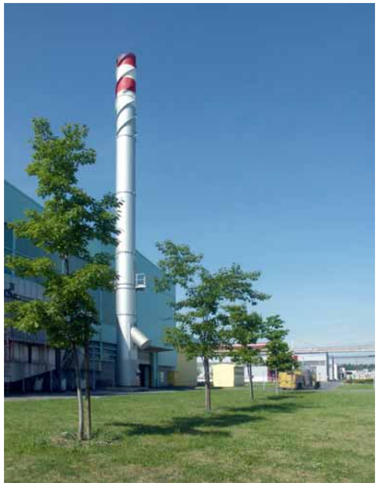
Čistilna naprava v livarni
