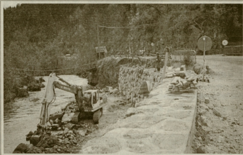
Na cesti med Ljubnim in Lučami je v gradnji eden najtežjih odsekov.
