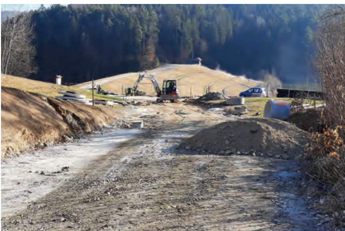
Izgradnja ceste OPPN Drtijščica.
