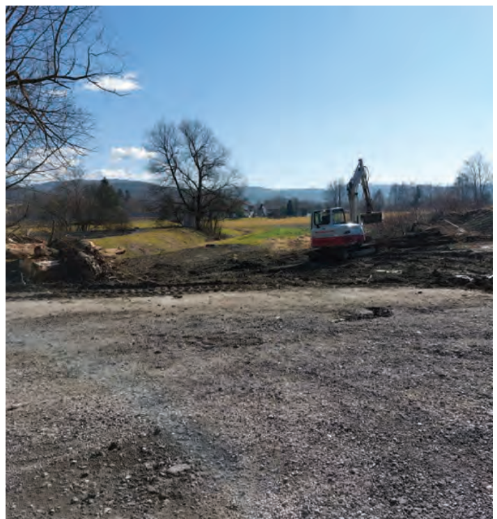
Gradnja Pump tracka v sklopu ureditve Športnega parka Šentvid.
