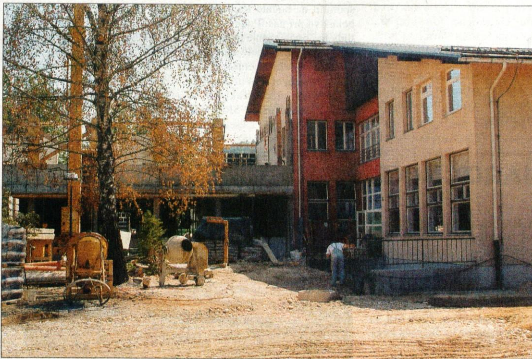
Gradnja prizidka pri osnovni šoli v Smladniku.
