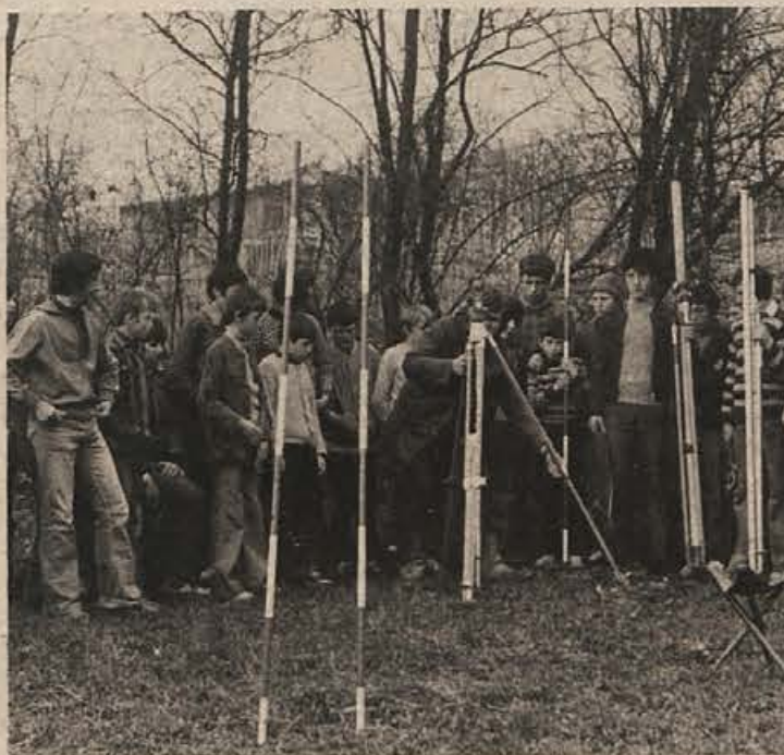
Na Bizelskem so 28. marca zakoličili temelje za novo šolsko poslopje. V montažni Marlesovi stavbi z osmimi učilnicami in telovadnico bo jeseni nadaljevalo pouk 230 učencev. Šolo na Bizelskem gradijo s samopriskevki občanov. (Foto: V. Podgoršek)
