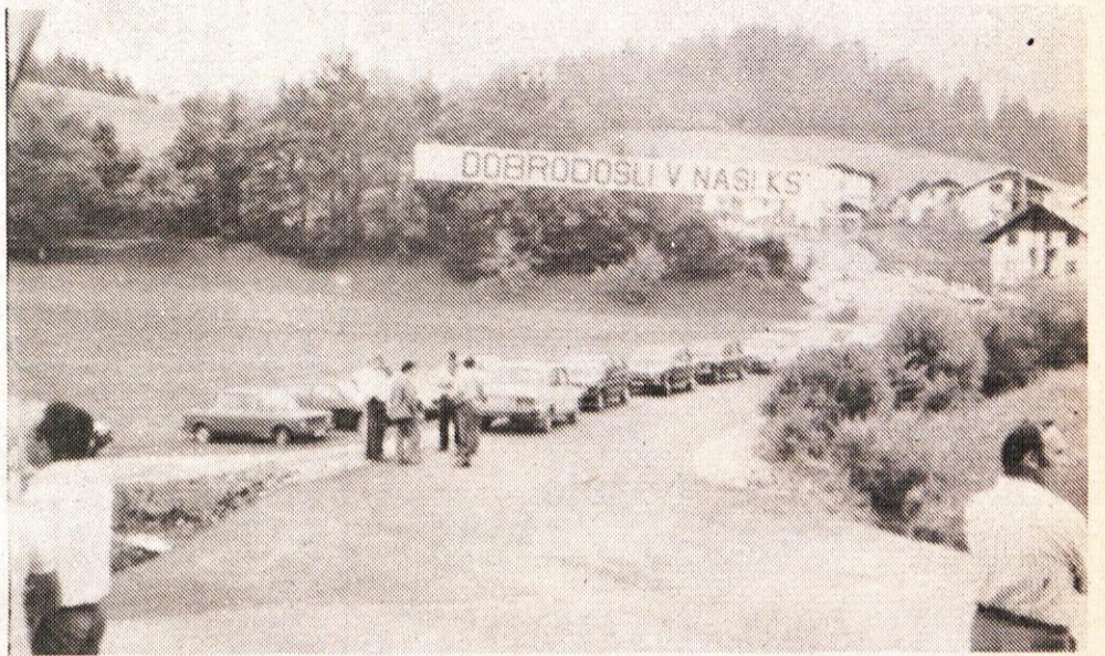
Otvoritev ceste Šmartno-Gradišče: »krajanje so 1300 metrov dolgo cesto zgradili z lastnim denarjem in prostovoljnimi delom, Cestno podjetje Ljubljana, tozdrževanje, je le strokovno nadziralo dela.« je dejal tajnik Krajevne skupnosti Šmartno Ivan Hribar.
