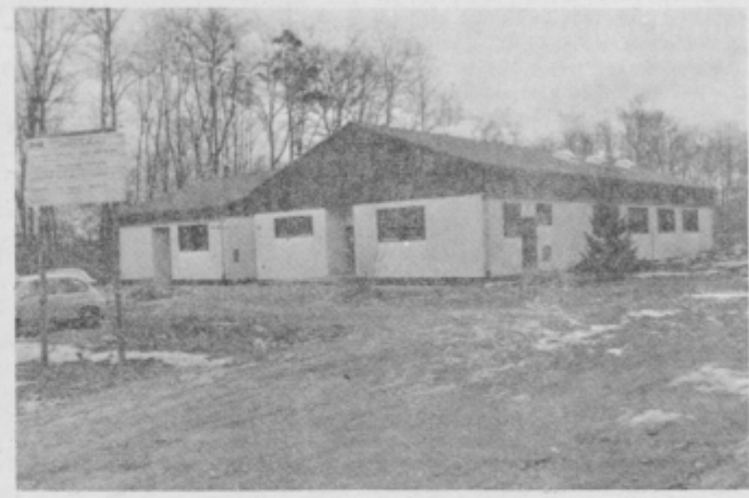
Novi objekt so zgradili v slabih desetih mesecih
