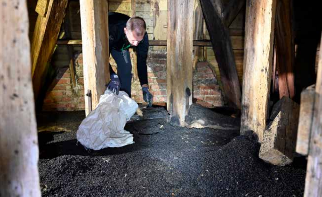
Čiščenje gvana na zvoniku v Vinici. Foto: Andrej Hudoklin
