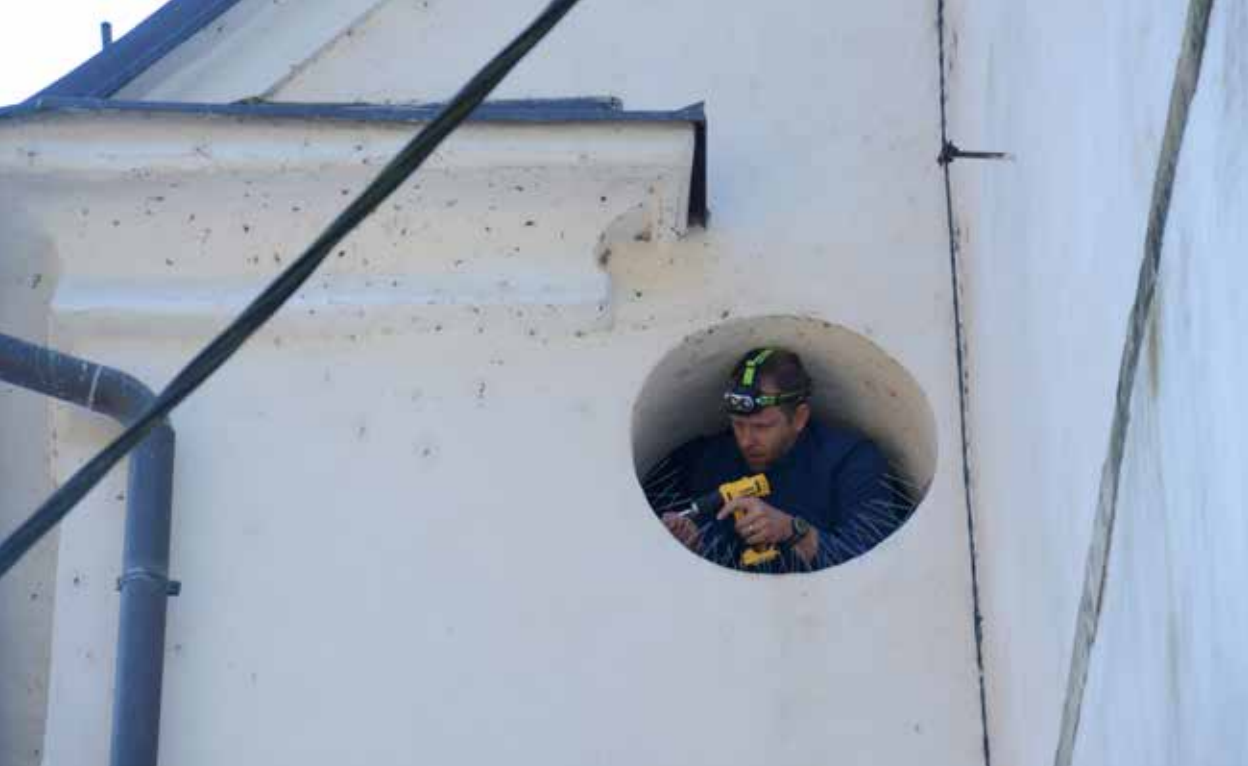
Urejanje preletne odprtine v Brestanici. Foto: Andrej Hudoklin
