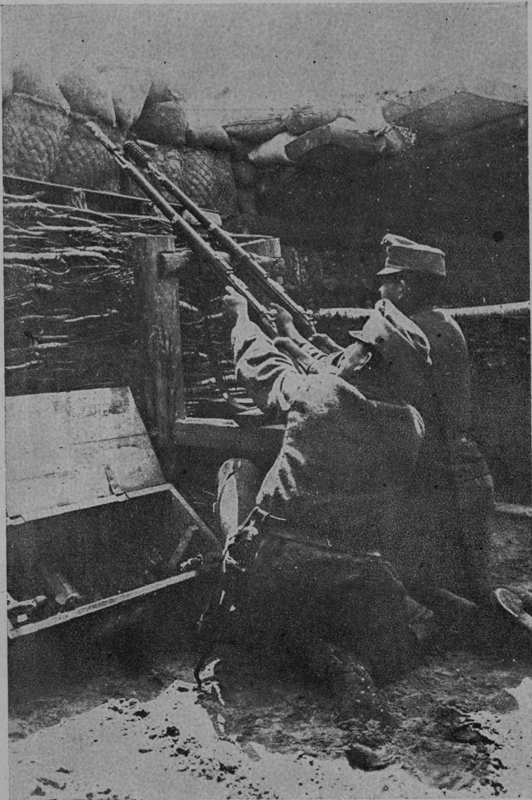
S soške fronte: Streljanje z minami iz strelskega jarka.
