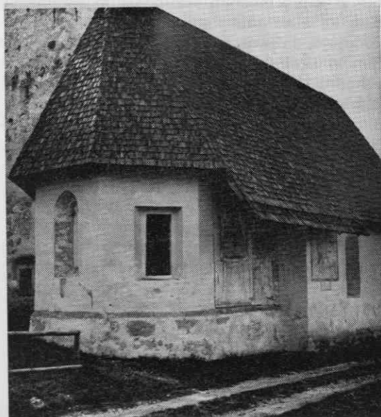
Bodešče, p. c. sv. Lenarta, zunanjščina s severovzhoda
