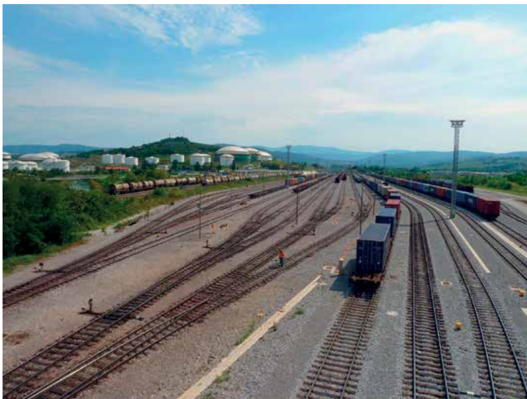
Slika 7: Razvrstilni tiri železnice pred Koperom (Foto: A. Polšak)
