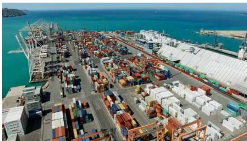
Sliki 4 in 5: Pogleda na kontejnerski terminal Luke Koper (Vir: A. Polšak (zgornja slika) in https://www.youtube.com/watch?v=8BGZ4s5BVaE (spodnja slika))
