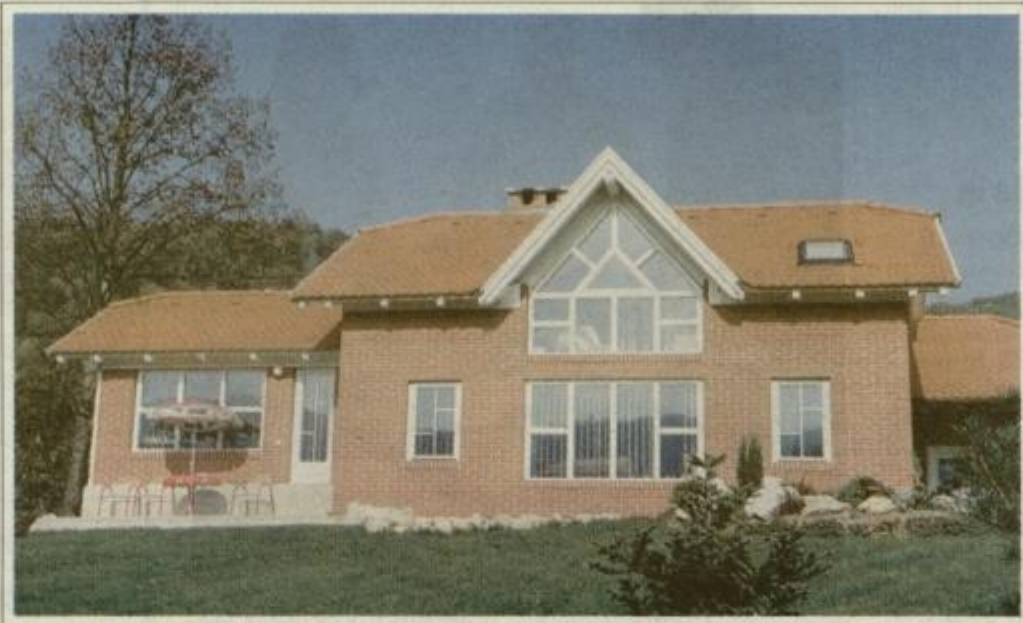
Hiša družine Klemen vzbuja pozornost mimoidočih. Les in zidaki, kokos za izolacijo, barve na vodni osnovi in čebelji vosek - in to je tudi vse.
