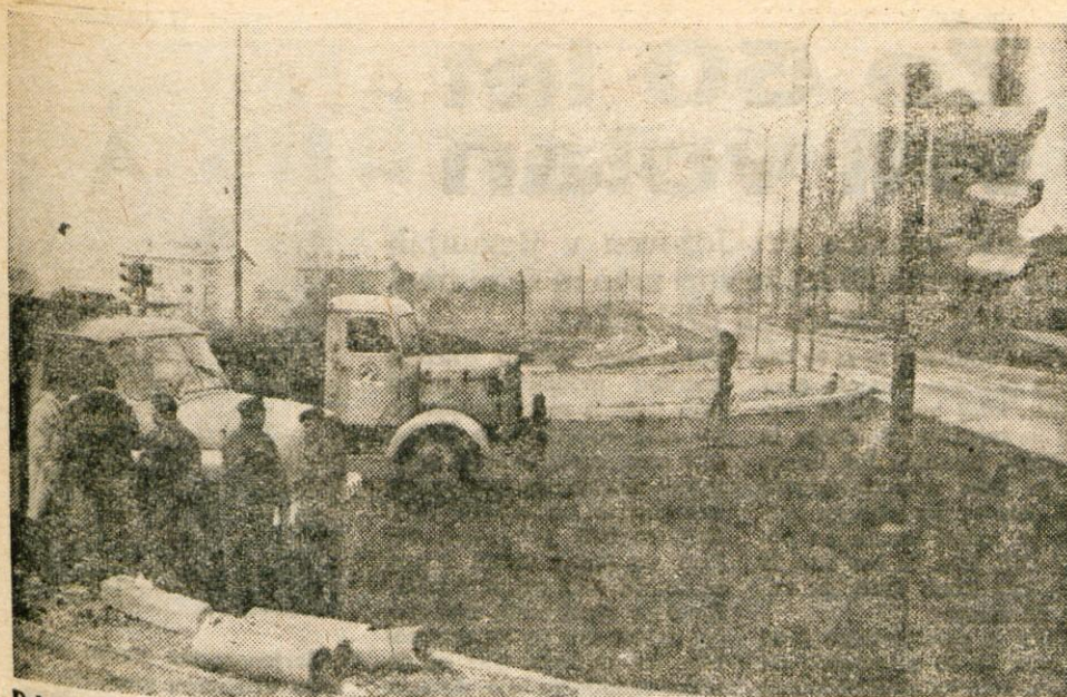
Dela na kranjski obvoznici gredo h koncu. Pred dnevi so delavci položili še zadnje metre grobe asfaltne plasti in postavili v križišču semaforje. Obvoznica bo dobila svoje uporabno dovoljenje seveda šele takrat, ko bo položena še fina plast asfalta. To delo pa se je zaradi trenutnega slabega vremena precej odmaknilo, s tem pa tudi otvoritev tja do konca leta ali še dlje. — Foto: F. Perdan
