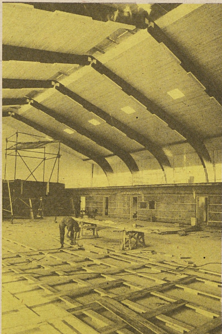
Razmeroma „mlada“ proizvodnja Hojinega TOZD „Tesarstvo“ so lepljeni nosilci. Slika nam prikazuje lepljeno leseno konstrukcijo telovadnice Železniškega šolskega centra v Ljubljani.
