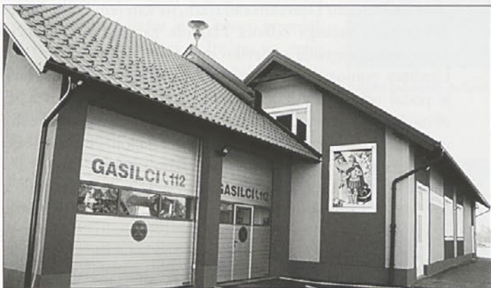
Gasilski dom v Slovenji vasi pridobil prizidek, v katerem je sodobno urejena garaža, dom pa je pred praznovanjem 40-letnice obnoven v notranjost, nova pa je tudi fasada na gasilskem domu.
