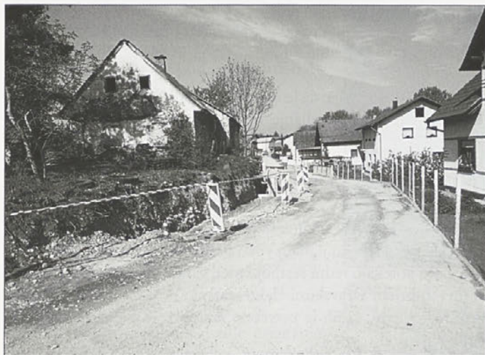
V Hajdošah se zaključujejo zahtevna dela po izgradnji kanalizacije.
