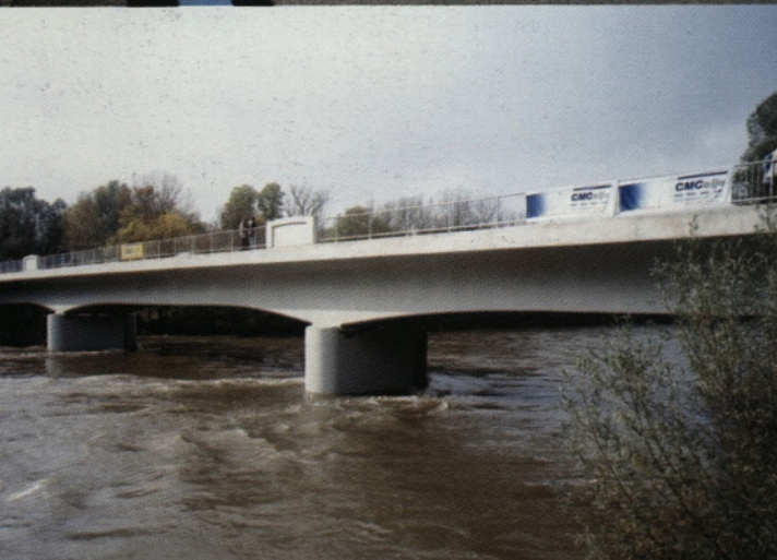
Rekonstrukcija mostu čez Muro in petih inundacij
