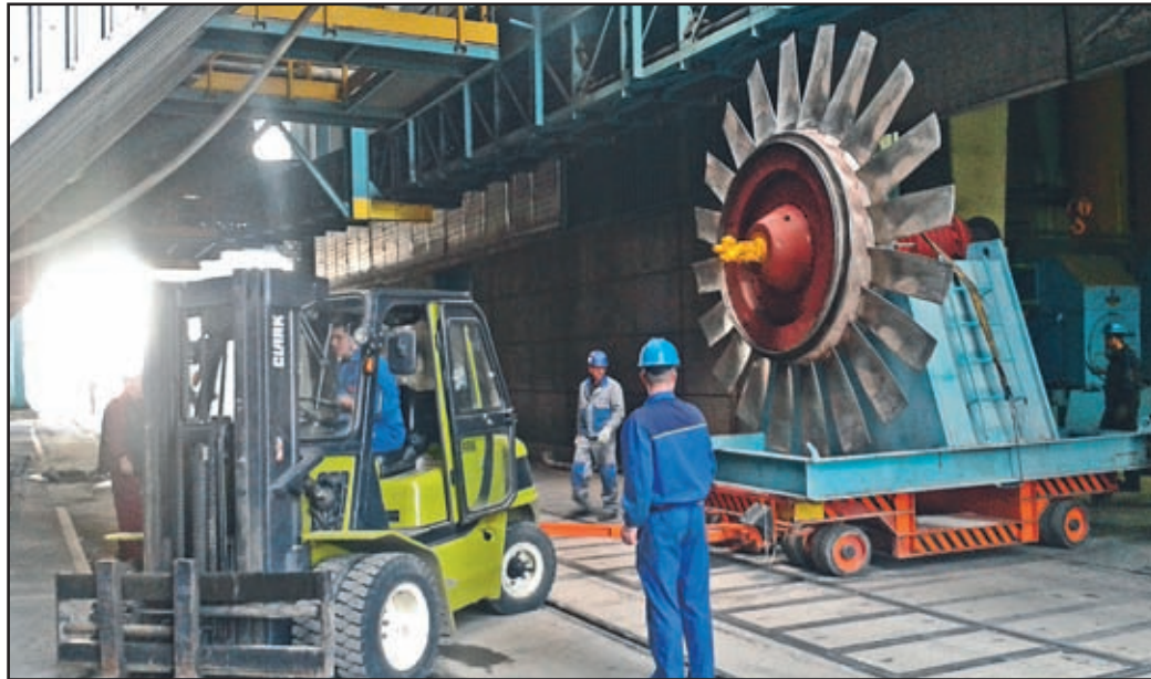
Demontaža ventilatorja (zgoraj) in montaža rotorja (levo)
