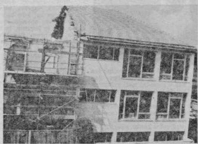
Gradbeno podjetje Remont iz Makol zaključuje dela na osnovni šoli v tem kraju. Tako se bliža koncu prva faza v izgradnji šolskega prostora v slovenjebistriški občini.
