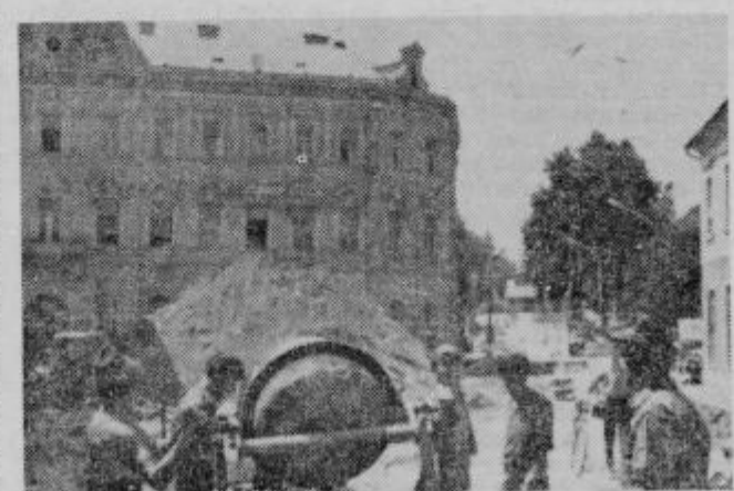
Ptujjske ulice in trg je veliko gradbišče. V ozadju velik kup zemlje, ki so jo morali odpeljati.
