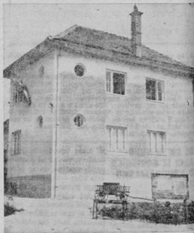
V Črešnjevem v slovenjebistriški občini so pred kratkim obnovili kulturni dom. Poleg nove fasade in preureditve dvorane so v zgradbi uredili tudi eno stanovanje ter tako obenem rešili dva problema.
