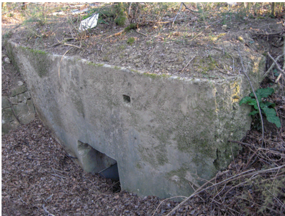
Bunker v Dekanih
