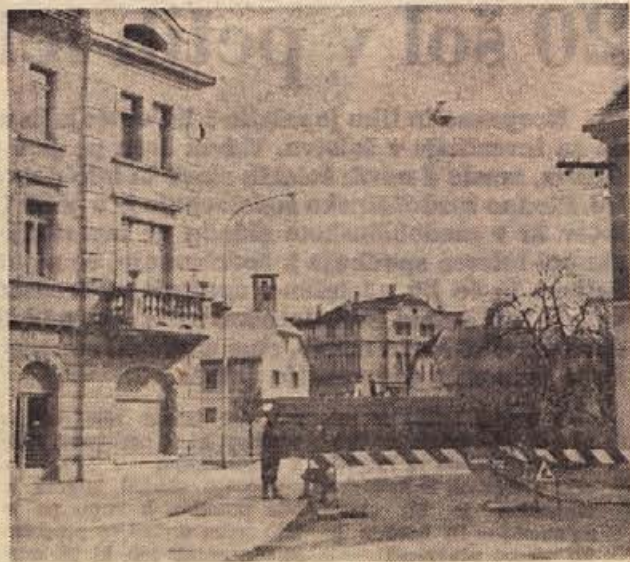
Most proti Rudniku bo zaprt približno 14 dni, ker polagajo na Roški cesti v Kočevju čez cesto cevi za novo kanalizacijo, ki bo odvajala odplake z levega brega Rinže za zapornice (Foto: Primc)
