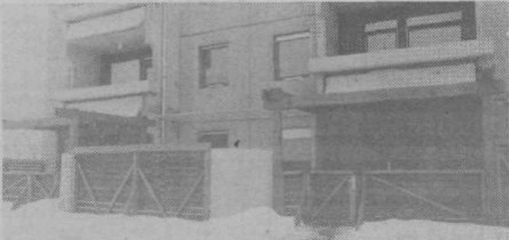
V enoti vrtca Angele Ocepke na Leninovem trgu 14 ima vsaka skupina otrok (tako kot v objektu A-24 na Leninovem trgu 9) svoj vhod. Vsaka skupina ima tudi svojo garderobo in sanitarije; razdelilna kuhinja je skupna. Prostor vrtca so popolnoma ločili od stanovanjskih prostorov v stolpnici — prednost takega načina gradnje vrtca pa je tudi ta, da bo kasneje brez velikih težav te prostore mogoče preurediti v stanovanja. — (Foto: D. J.)
