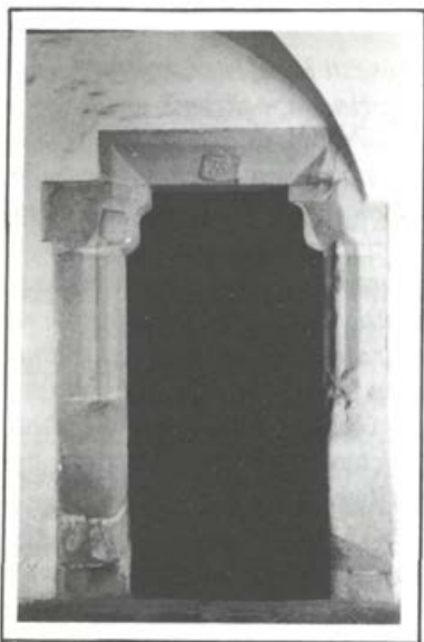
Poznogotski portal s sočasnimi vratnicami v pritličju severnega trakta grajskega jedra
