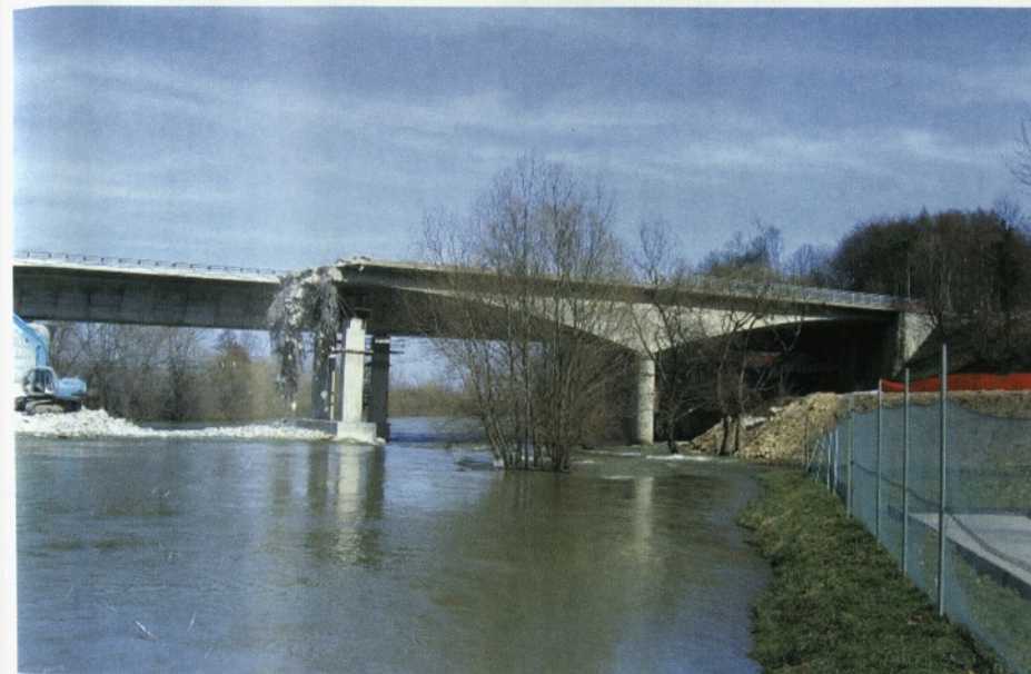
Slika 4 • Porušena je polovica mosta
