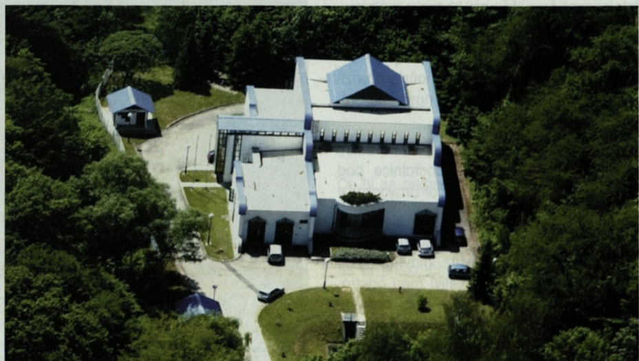
Slika 6 • Čistilna naprava za prezračevanje obrežnega filtrata in čiščenje železa in mangana. Levo dva prekrita negativna vodnjaka
