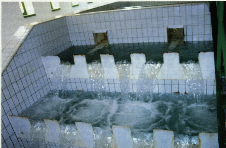
Slika 7 • Prezračevanje obrežnega filtrata pred filtracijo
