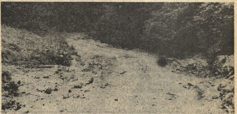
Pred ujmo asfaltiran sedaj goli del ceste na Pečovje
