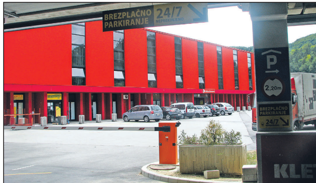
Zapornice pri vходу na parkirišče pred Rdečo dvorano so vandali v zadnjem času poškodovali že petkrat. Zato kamere sedaj nadzorujejo tudi zunanje parkirišče pred dvorano.
