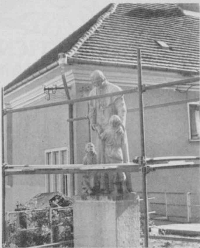
Restavratorska dela na Slomškovem kipu
