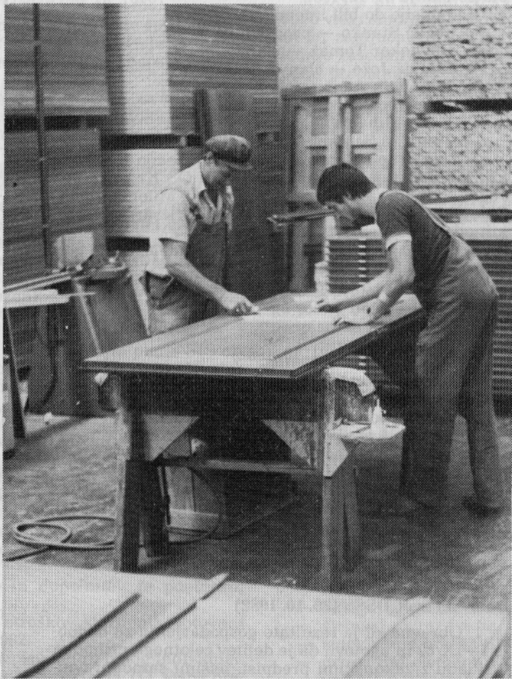
Montaža okrasnih letvic (foto Ažman)
