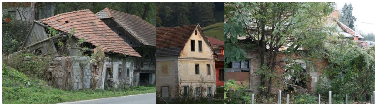
Slika 15: Propadajoči stanovanjski objekti. Foto: Naja Marot, november 2009
