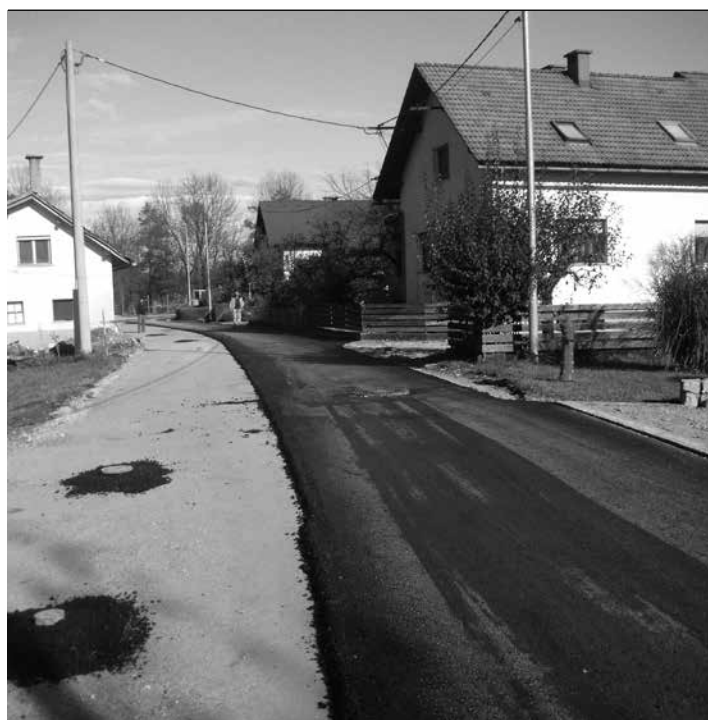
Asfaltiranje v Strahomerju
