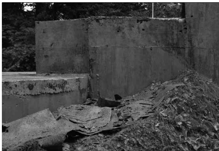
Sanacija izolacije na vodohranu Gornji Ig
