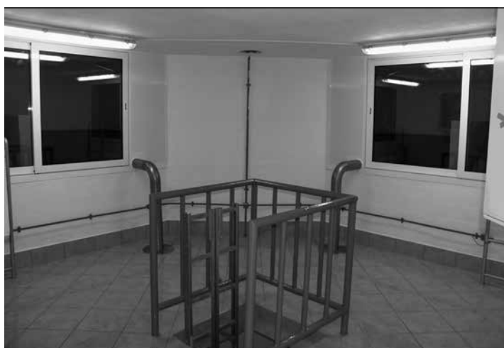
Sanacija vodohrana Kurešček
