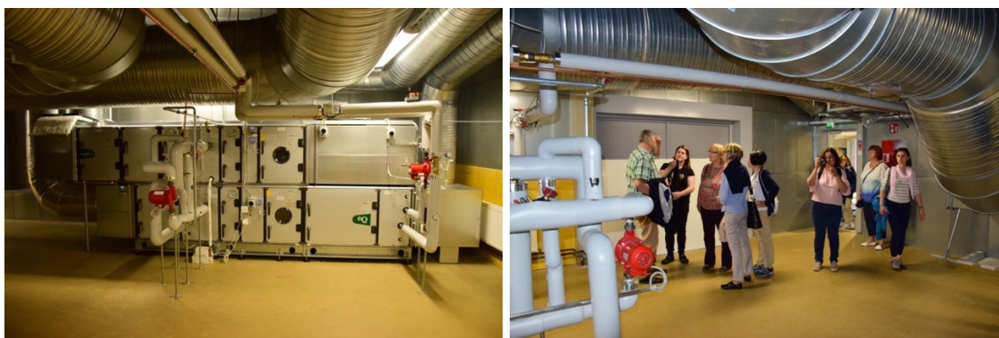
Slika 5: Soba s prezračevalnimi napravami (vir: InAirQ skupina)
