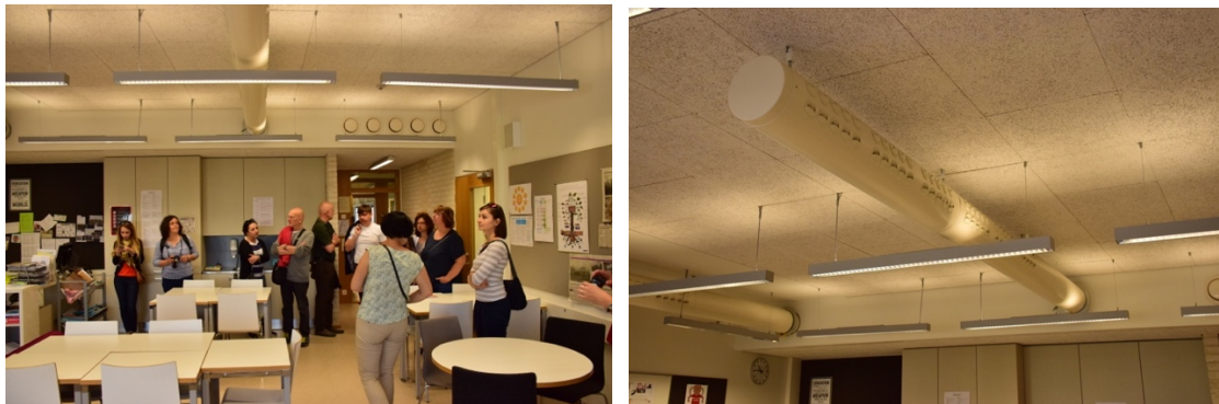
Slika 4: Učilnice in mebansko prezračevanje (vir: InAirQ skupina)
