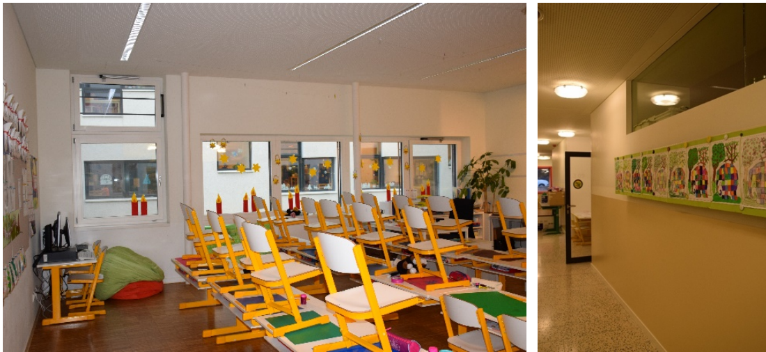
Slika 1: Učilnice – okna: naravna svetloba, naravno prezračevanje (levo); hodniki – line za prezračevanje, ki povezujejo hodnik in učilnico (desno) (vir: InAirQ skupina)
