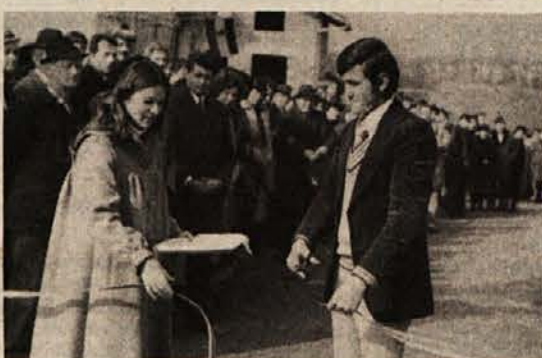
Otvoritev asfaltirane ceste Črnemelj - Butoraj - Velika Lahinja
