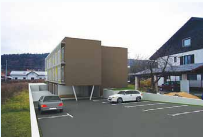
Stavba, v kateri je 22 bivalnih enot, je zgrajena po standardih za gradnjo pasivnih hiš. Foto: JSS MOL
