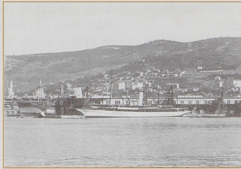
Pogled na Greto iz pristanišča.
