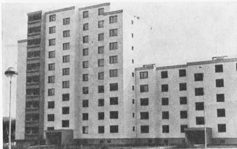
Nova stanovanja za delavce na Javorniku
