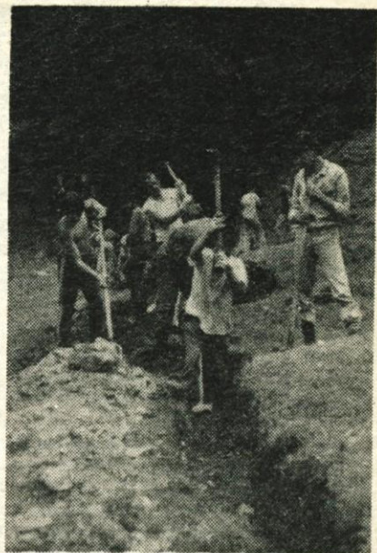
Pri izkopu jarka za vodovod na Podkužah
