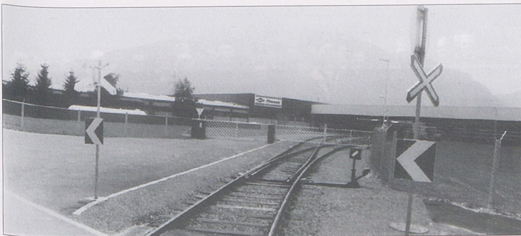
Filterwerk je priključen tudi na podjunsko železnico. 32 % transporta danes odvija tovarna prek železnice, kar je seveda znižalo stroške.
