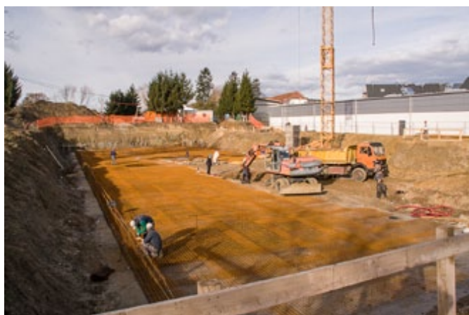
Trenutno so v teku pripravljalna dela za ulitje temeljev in nadaljnjo izgradnjo.
