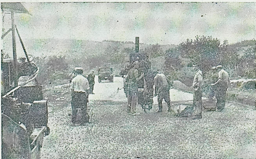
Ta teden je odprt za promet predzadnji urejeni del nove ceste Koper—Ljubljana na odseku Petrinje—Kozina. Slika kaže delavce, kako končujejo zadnja dela pred dokončanjem cestišča na začetku novega odseka pod Petrinjami.
