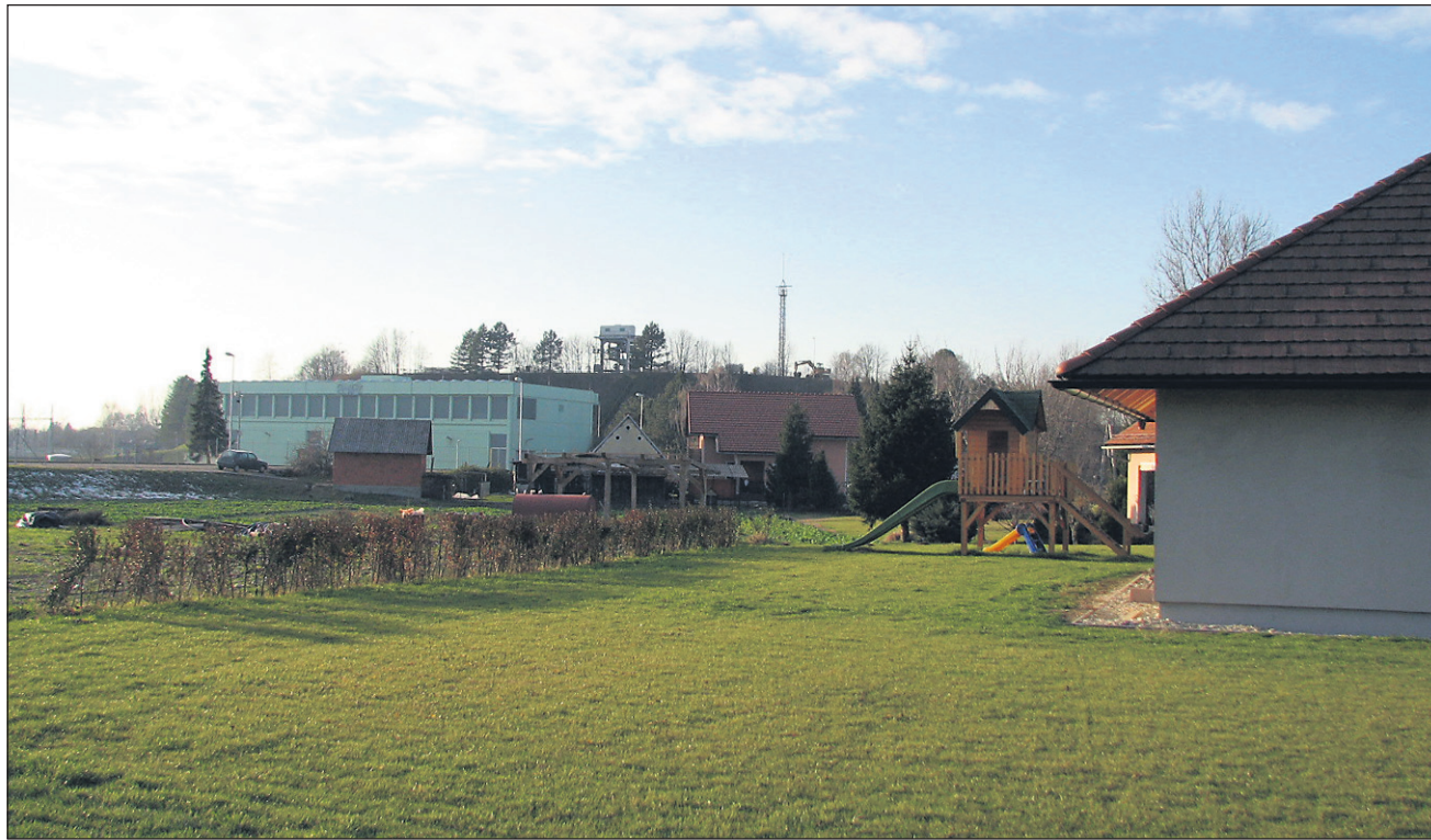
Občani Formina so prestrašeni in zaskrbljeni, saj ne vedo, kakšne so dejanske poškodbe HE Formin, kako in kdaj jih bodo sanirali, želijo oz. zahtevajo pa tudi srečanje z odgovornimi v Dravskih elektrarnah Maribor.
