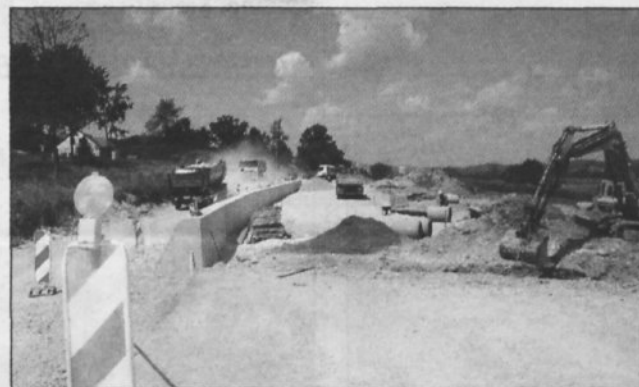
Rekonstrukcija ceste pri Ekonomiji
