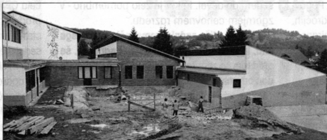
V prizidku bosta dobili svoj prostor novi učilnici devetletke (foto: Benjamin Kanjir)
