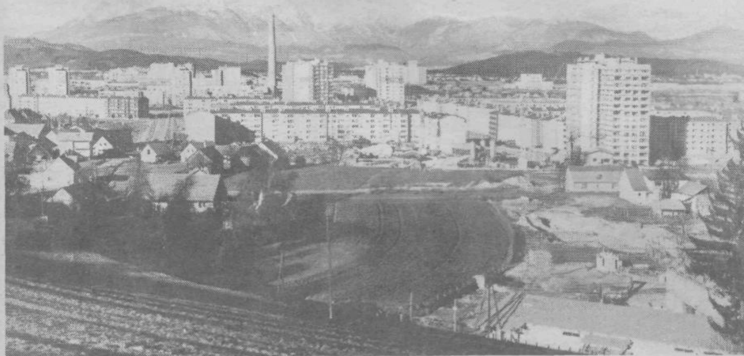
ŠTEPANJSKO NASELJE — Gradnja Štepanjskega naselja, ki so z njo začeli v letu 1973, je prav zdaj v najlepšem razcvetu. Od 3000 načrtovanih stanovanj je do danes 1750 že vseljenih. Do jeseni bodo za vselitev pripravljene še trije večji objekti. Leta 1978 bo zgrajenih še zadnjih 166 stanovanj. Takrat bo Štepanjsko naselje štelo okrog 11.000 prebivalcev (Foto Nuša Javornik)
