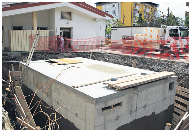
Aprila so v Domu upokoencev pričeli graditi plinsko kotlovnico.
