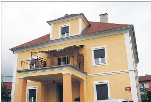
Na vrhu te večstanovanjske zgradbe na Zoisovi poti 15 so štiri dimniki, ki so bili sanirani.
